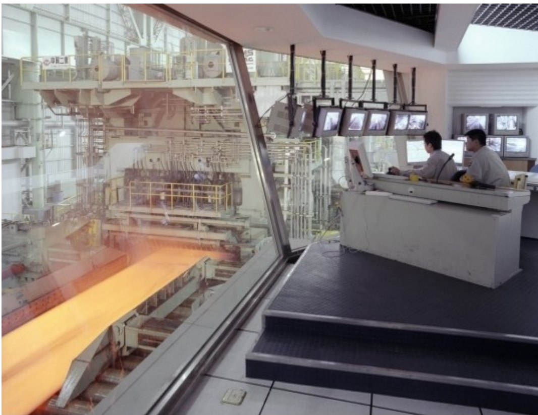
Steuerstand mit Blick auf das 5 m Grobblechwalzwerk - Baoplate, VR China Control pupil looking onto the 5 m Heavy Plate Mill - Baoplate, PR China
